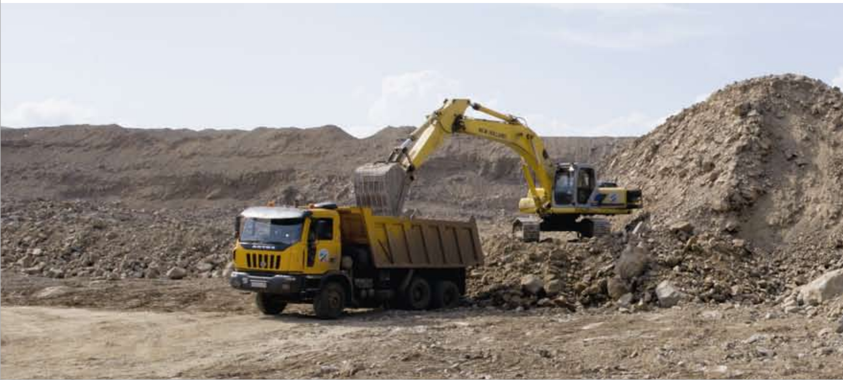
г. Чита, строительство автомобильной дороги
