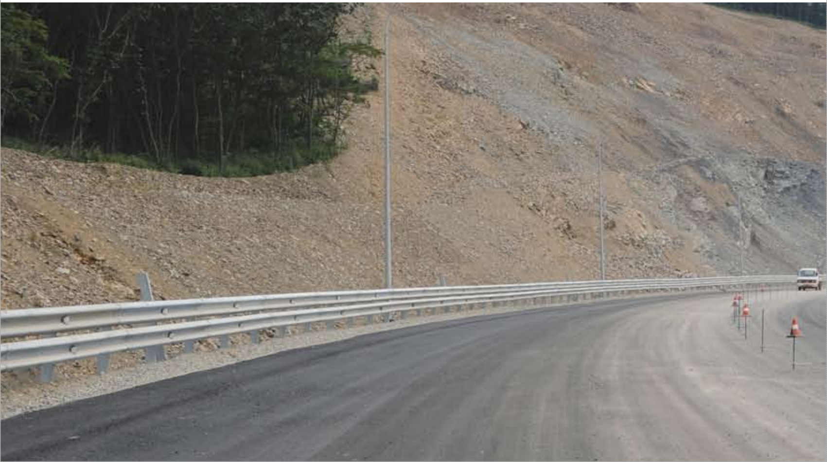
строительство автомобильной дороги пос. Новый – полуостров Де-Фриз – Седанка – бухта Патрокл. Город Владивосток
