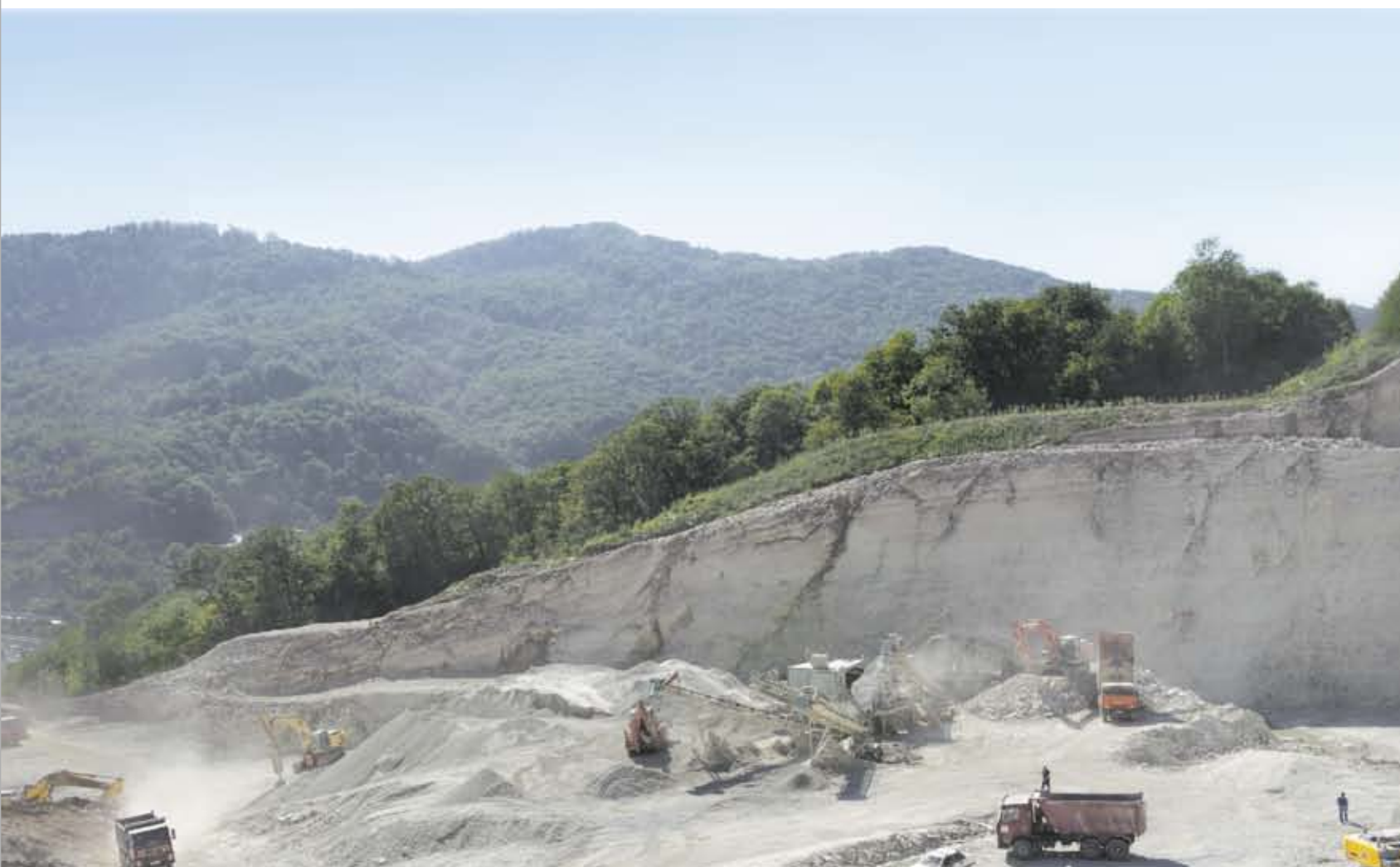
разработка Ахштырского месторождения камня в рамках строительства Олимпийских объектов г. Сочи
