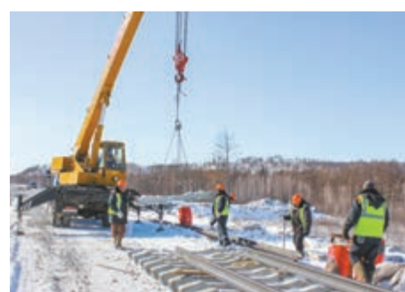
Укладка ВСП на разъезде Мохортов, февраль 2015 года
