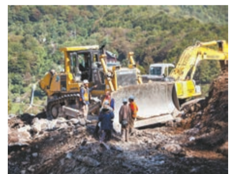
Строительство совмещенной автомобильной и железной дороги Адлер — горноклиматический курорт Альпика-сервис, май 2010 года
