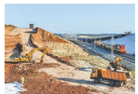
Строительство железнодорожной линии Журавка — Миллерово в обход Украины, май 2017 года
