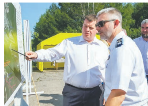
Генеральный директор ПАО «Бамстроймеханизация» Сергей Макаров рассказывает министру транспорта РФ Евгению Дитриху о реконструкции федеральной дороги Большой Невер — Якутск.
