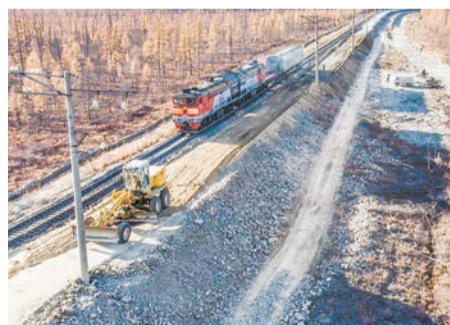
Механизаторы готовят земляное полотно под укладку второго пути на БАМе
