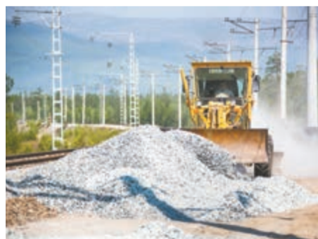
Строители готовят земполотно под укладку верхнего строения пути на перегоне Олекма — 1945 км
