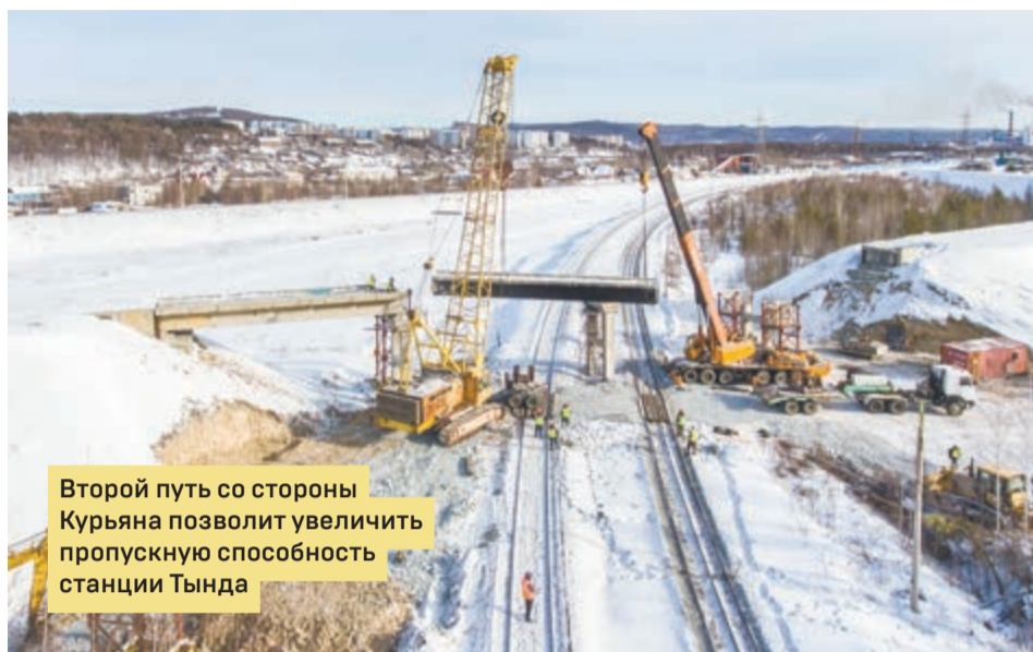
Мостовики завершили демонтаж балок на путепроводе через Малый БАМ
