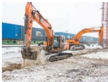
На перегоне Тас-Юрях — Юктали выполнен комплекс мероприятий для защиты железной дороги от наледей
