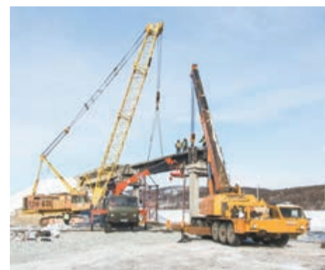
Мостовики завершили демонтаж балок на путепроводе через Малый БАМ
