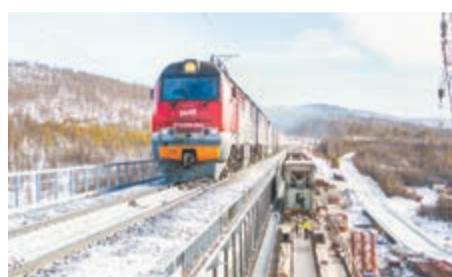
Поезда уже идут по новому мосту через реку Кованта, а в этом году здесь завершат строительство пролетов под второй путь.
