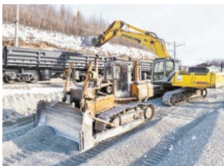
На разъезде Студенческом ведется устройство дренажной системы
