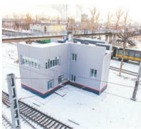
В рамках реконструкции на станции построены здания для путейцев, составителей поездов
