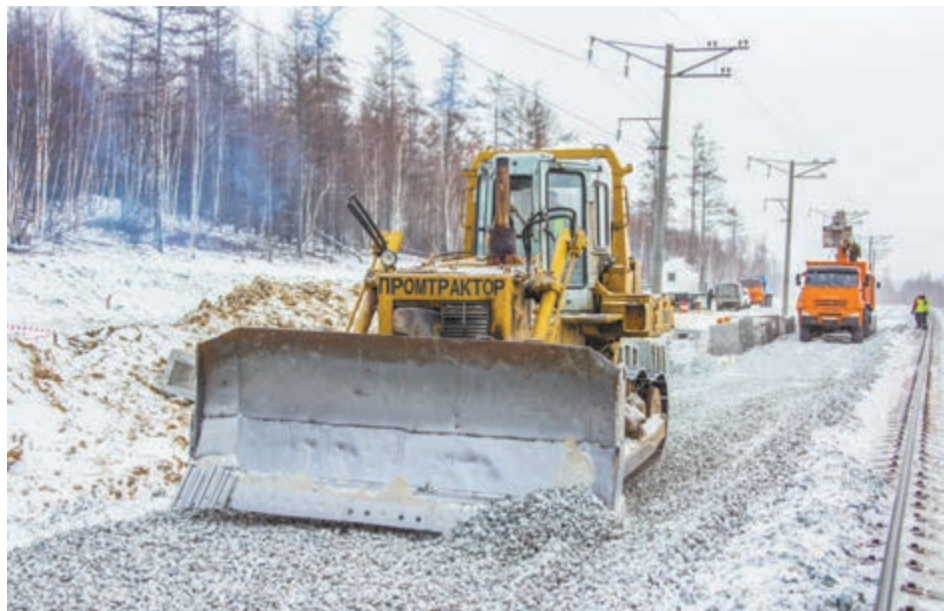
Механизаторы расширяют земполотно под второй путь до проектных отметок
