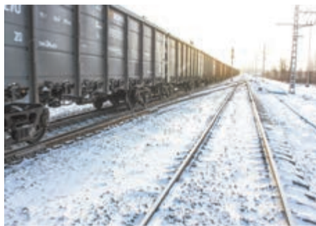
Удлинение путей на разъездах, станциях линии Волочаевка — Комсомольск позволило увеличить грузоперевозки.
