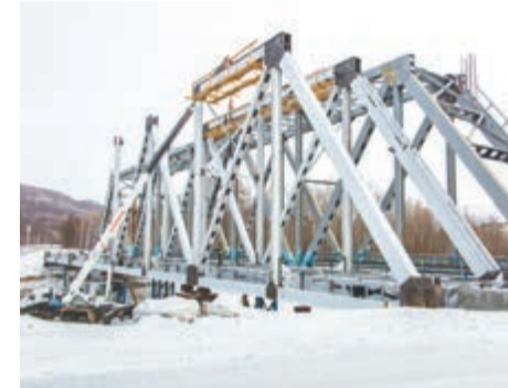
На станции Юктали строят мост под второй путь
