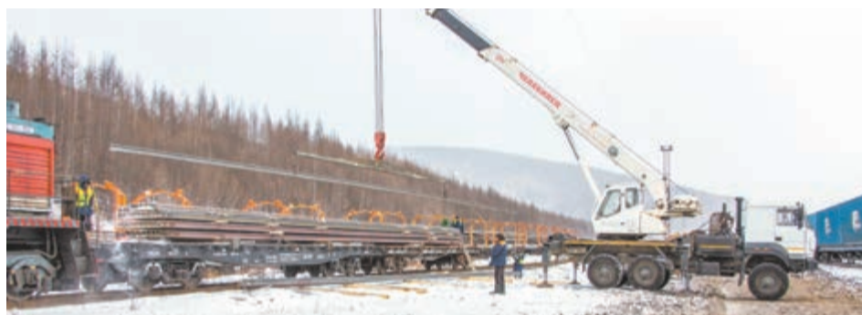
На перегоне Тас-Юрях - Юктали началась укладка рельсошпальной решетки на втором пути
