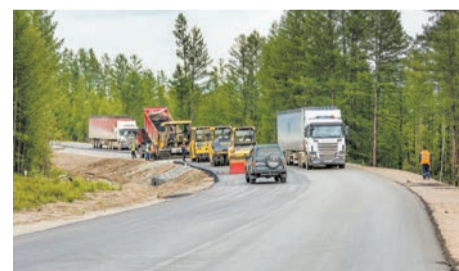
Новый асфальт укладывается с учетом грузонапряженности трассы «Лена».
