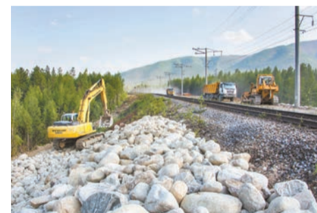
Основной объем земляных работ при строительстве объектов на БАМе связан с устройством охлаждающей наброски для сохранения вечной мерзлоты.
