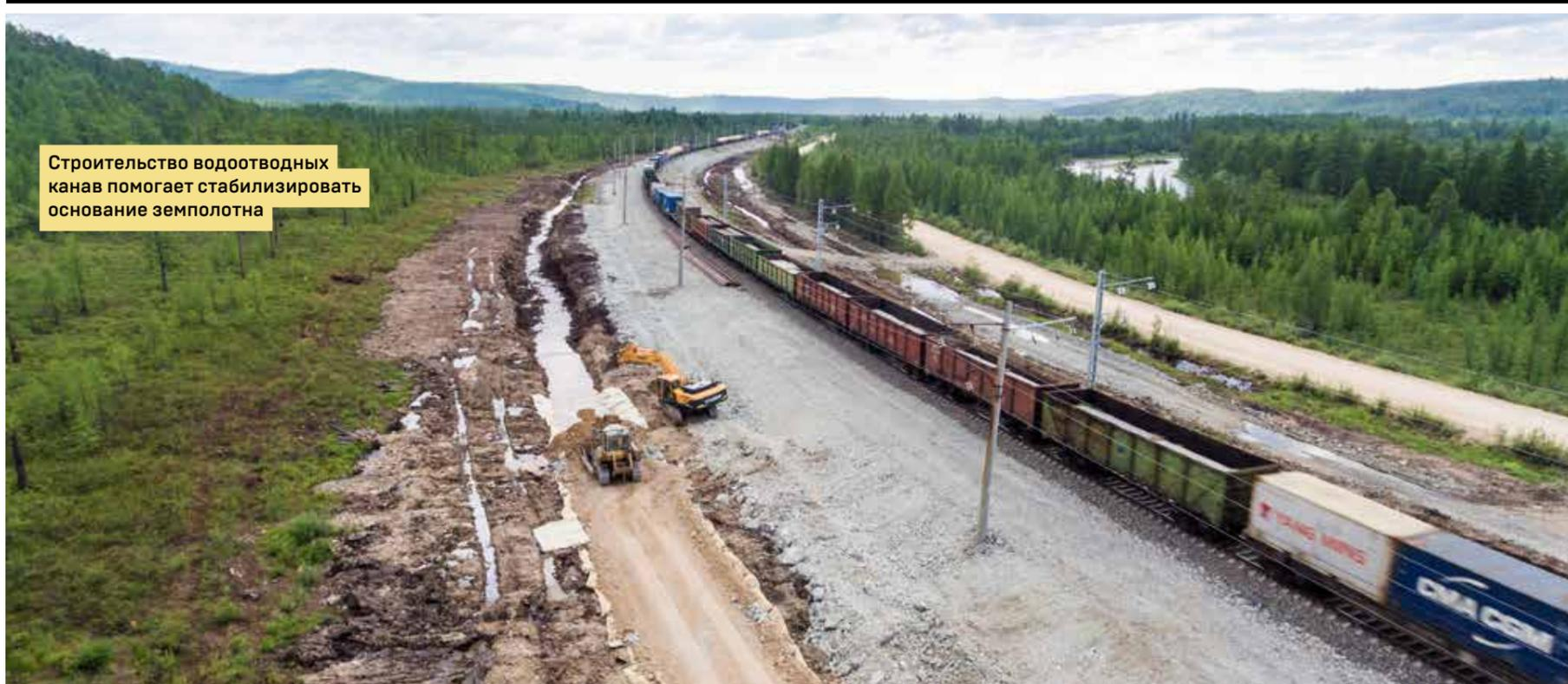
Строительство водоотводных канав помогает стабилизировать основание земполотна
