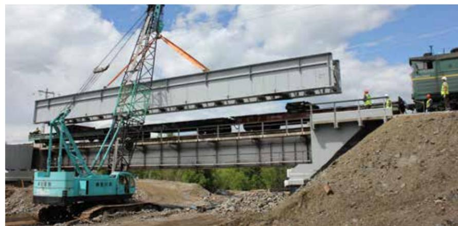
На приемоотправочном пути строящегося разъезда Моховой установлено пролетное строение длиной 33,6 метра через ручей Маристый. Бригаде «Мостоотряда-43» понадобилось всего 3,5 часа, чтобы смонтировать балку, изготовленную на заводе «Улан-Удэстальмост» на береговые опоры. Работу осложняли расположенные над осью пути воз-
