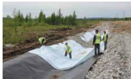
Для укрепления водоотводных каналов вдоль развязок строители используют геомембрану и геотекстиль
