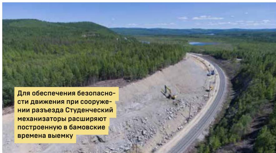
Для обеспечения безопасности движения при сооружении разъезда Студенческий механизаторы расширяют построенную в бамовские времена выемку
