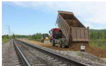
На разъезде Побожий механизаторы отсыпали около 3 километров земполотна под второй путь
